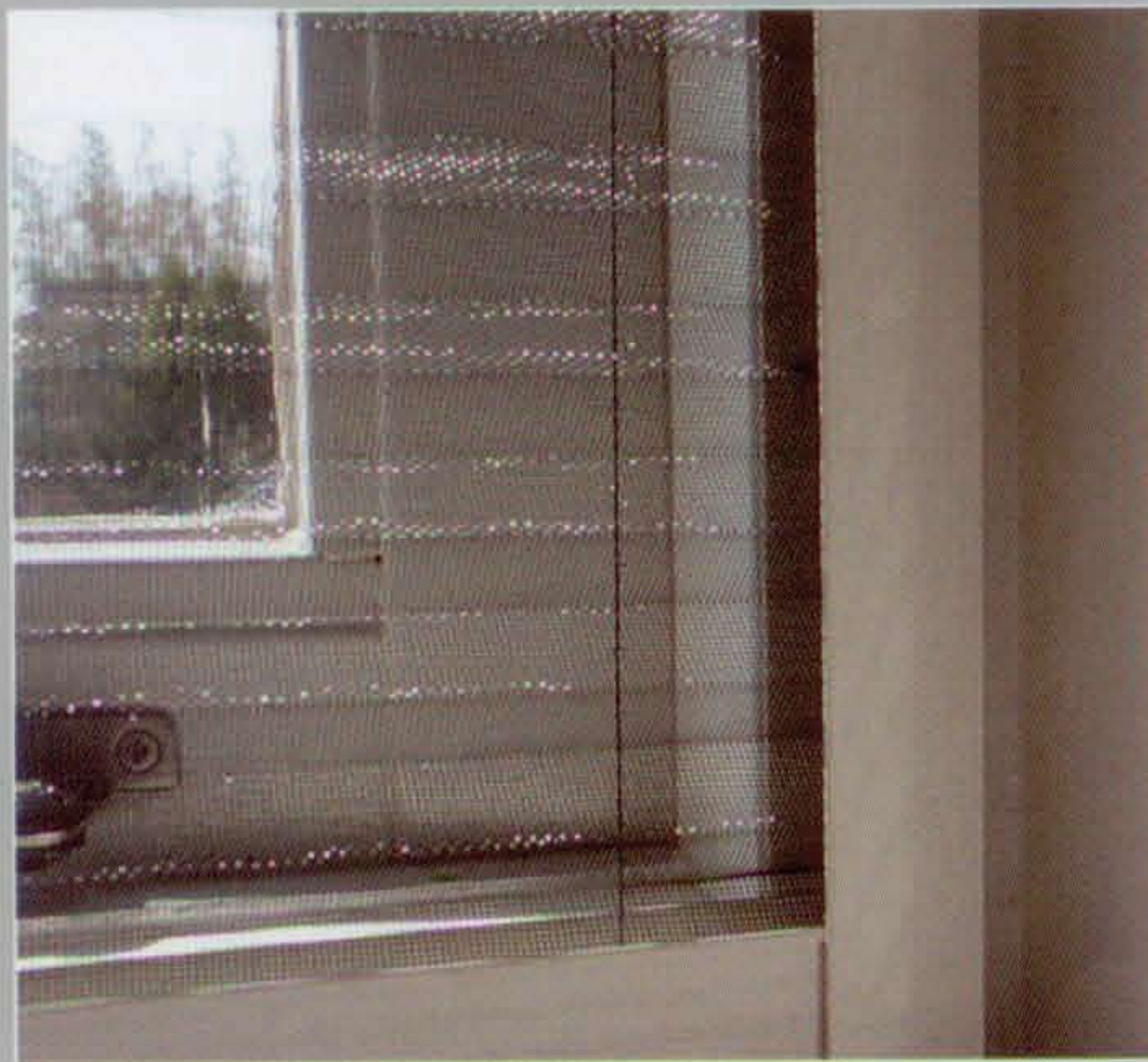
Montage op het kozijn
